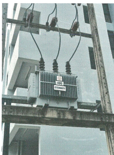
รูปภาพที่ 2.15 หม้อแปลงไฟฟ้า
