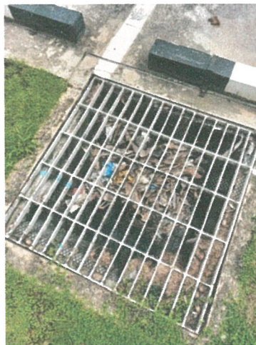
รูปภาพที่ 2.12 ตะแกรงดักขยะและวางระบายน้ำ
