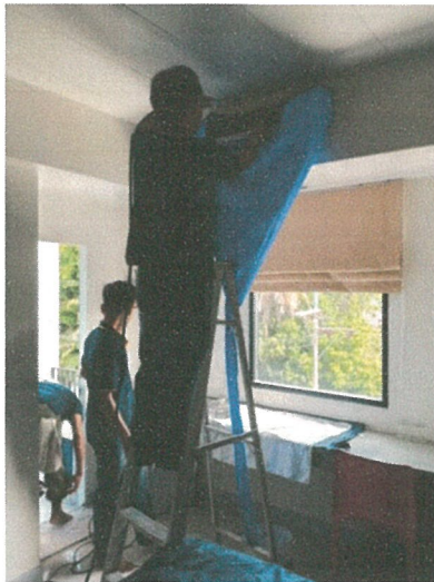
รูปภาพที่ 2.37 การล้างเครื่องปรับอากาศ
