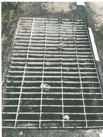
รูปภาพที่ 2.12 ตะแกรงดักขยะและวางระบายน้ำ
